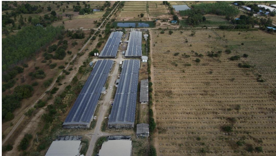
โครงการโรงไฟฟ้า จ.นครราชสีมา
